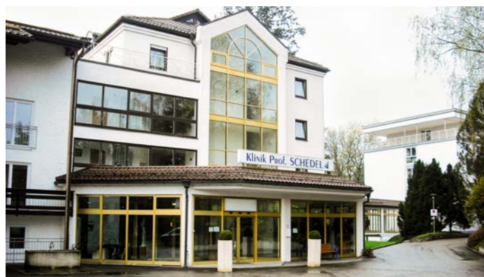
Die Klinik Prof. Schedel in Kellberg (Landkreis Passau) war ein Referenz- auftrag der Peter Kasberger Baustoff GmbH
